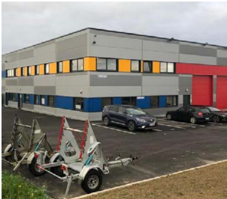
Le premier First Park est construit dans le parc d'activités Henry-Potez n°1.
